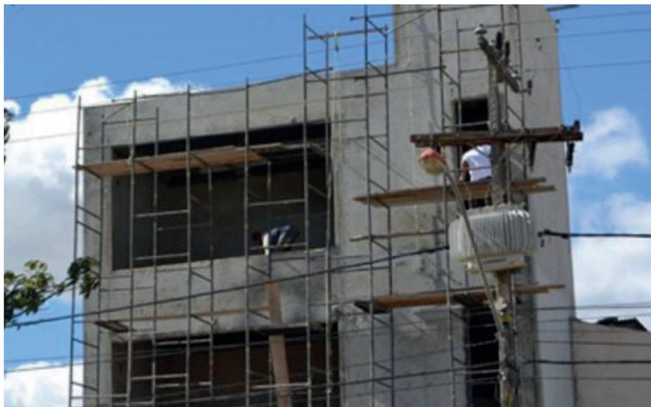
ternas, é muito comum que materiais como vergalhões, escadas, andaimes, e canos metálicos sejam transportados de um ponto até outro. A aproximação de objetos metálicos com a fiação de energia pode fazer com que eles também fiquem energizados, causando descargas elétricas que podem resultar em acidentes muito graves, inclusive fatais. Além disso, construir embaixo da
