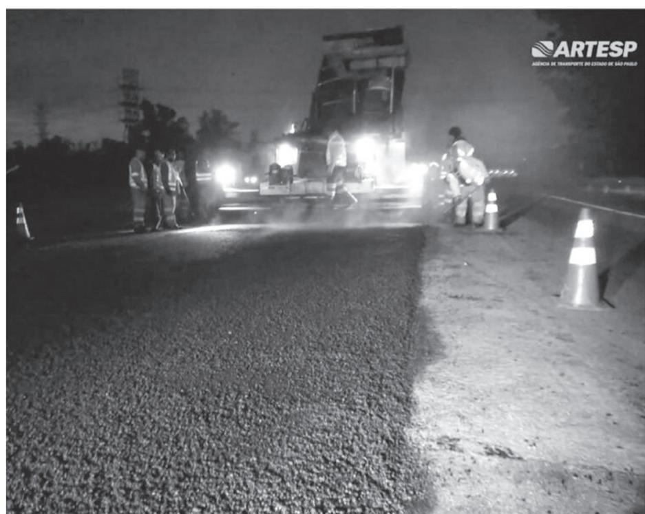
ção de um novo pavimento na rodovia, é realizado o processo de fresagem.
